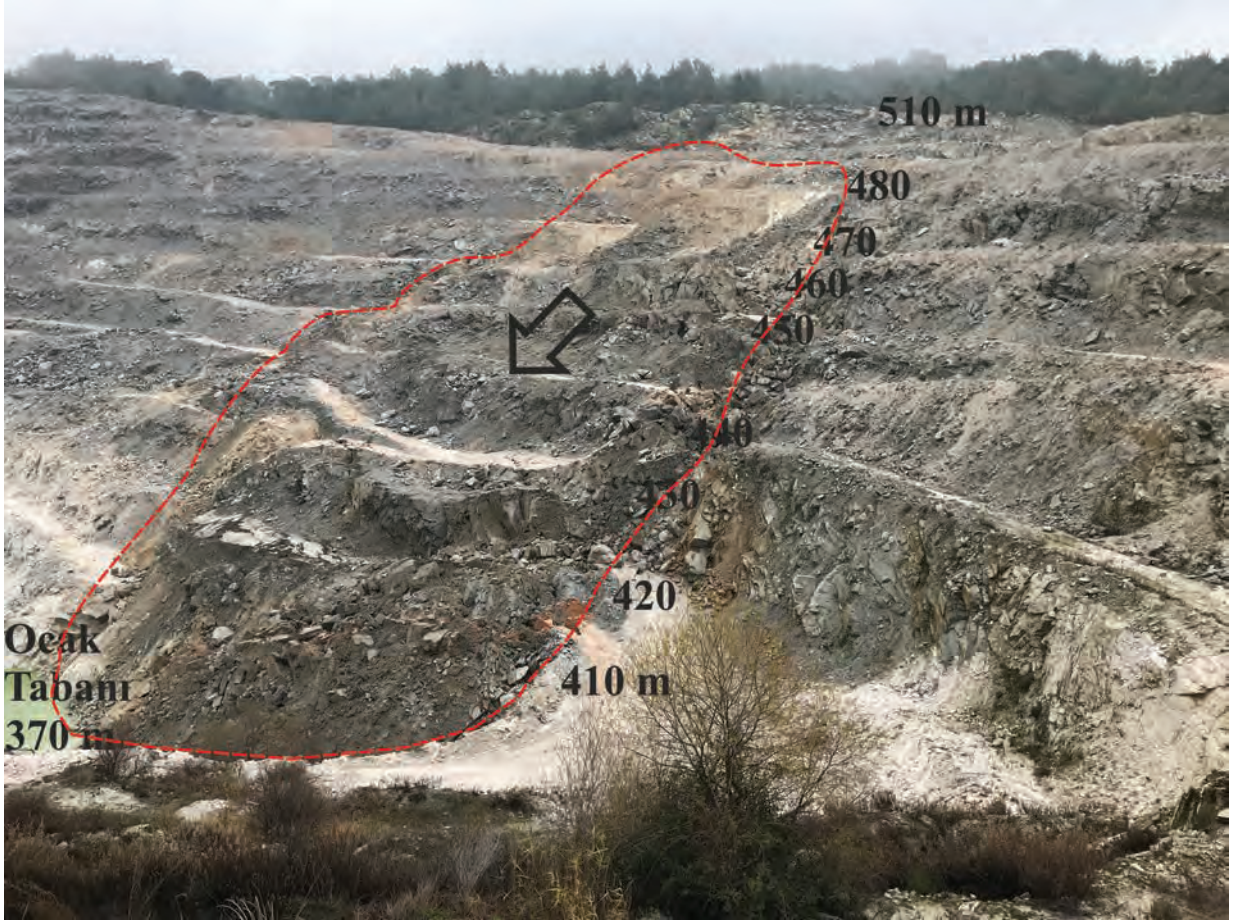
Şekil 12. Heyelan sonrası oluşan topoğrafya (19.12.2018, sabah: 7:30).
